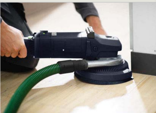
Простое шлифование паркета у самой стенки.
