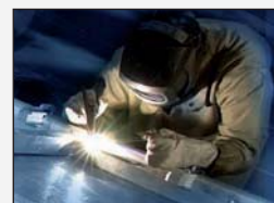
Идеальная TIG сварка на монтаже
