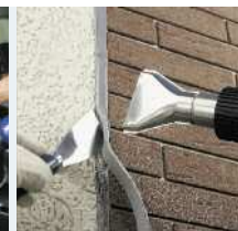
Удаление стыковой замазки
