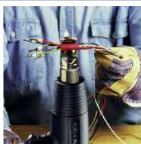
Усадка изоляции кабеля
