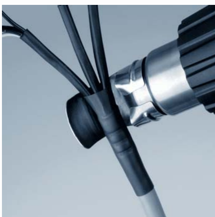
Термоусадка оболочки кабеля
