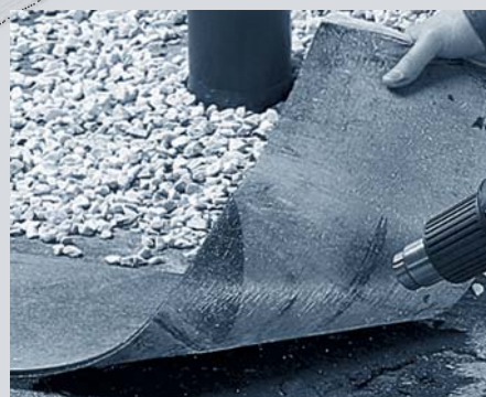
Сварка кровельного картона
